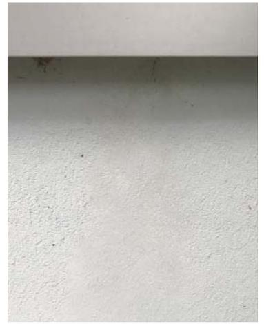
一見きれいに見える新築の基礎も、コンクリートの乾燥収縮でヘアクラックと呼ばれる細かなひび割れが発生することがあります。インサルクラックシャットは微細なひび割れを簡単にカバー。ひび割れが目立たなくなりました。
