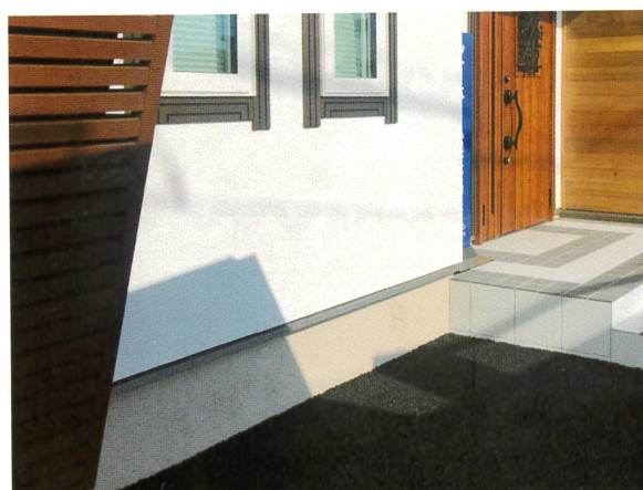
〈施工〉No.5 グラニットベージュ
