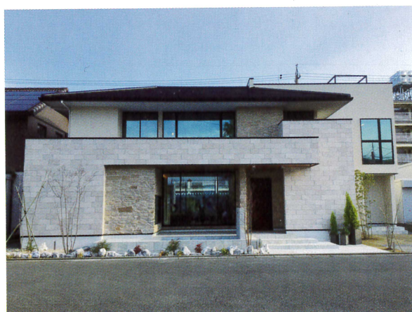
〈施工〉No.4 グラニットホワイトグレー
